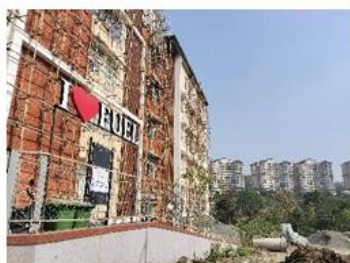
写真：学校の建物（まだ工事中）
